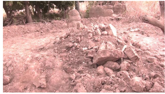
Etat du tata au lancement des travaux en 2024
